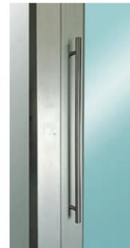
Dettaglio maniglia tubolare inox in acciaio
